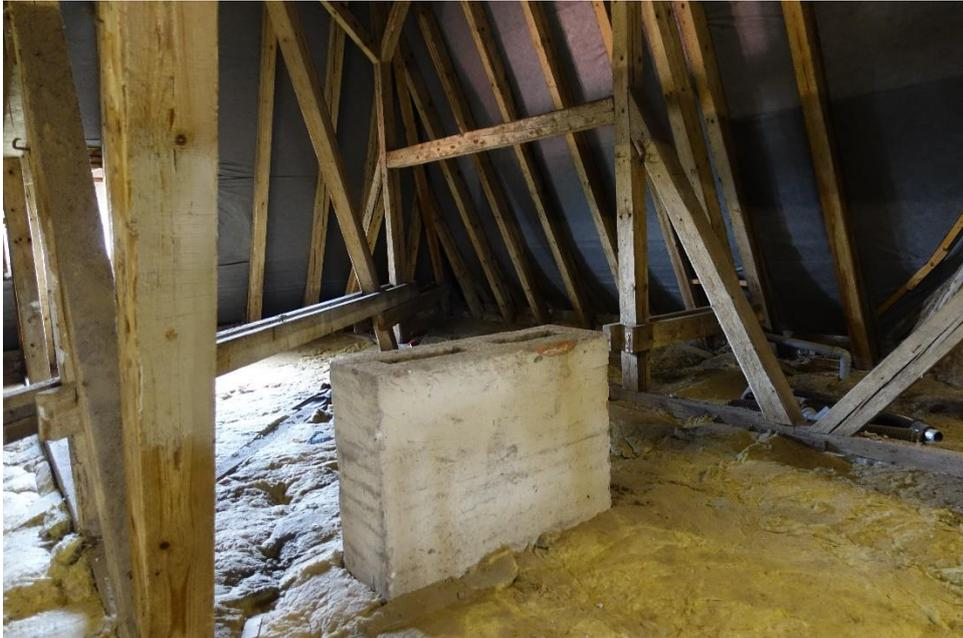
**Abbildung 5** Lüftungskanäle auf dem Dachboden (Quelle: LAV)
