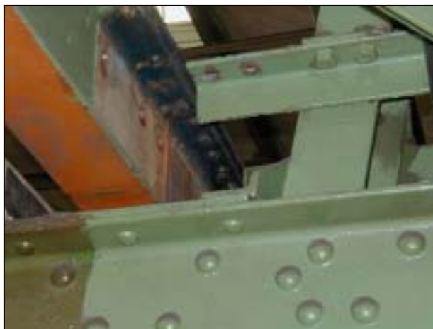
Abb. 38 (oben) Einbindung der Kranbahn in die Fachwerkkonstruktion der Halle
