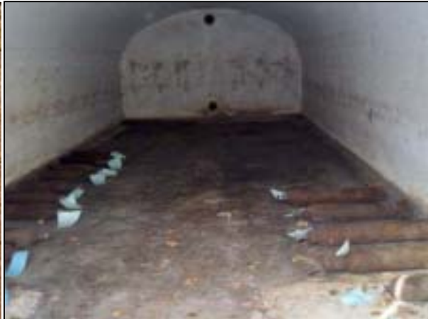
Abb. 33 Im Bunker zwischengelagerte Gasflaschen
