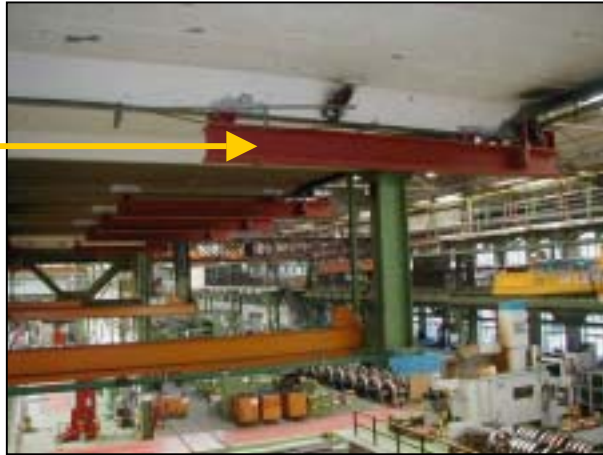
Abb. 37 Einbau spezieller Unterzüge in die vorhandene Hallenkonstruktion
