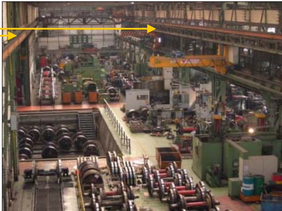
Abb. 36 Blick auf die zu rekonstruierende Krananlage
