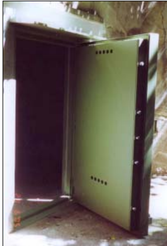
Abb. 28 Neue Bunkertür
