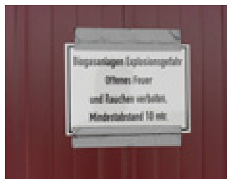
Abb.13 Falsche Kennzeichnung explosionsgefährdeter Bereiche
