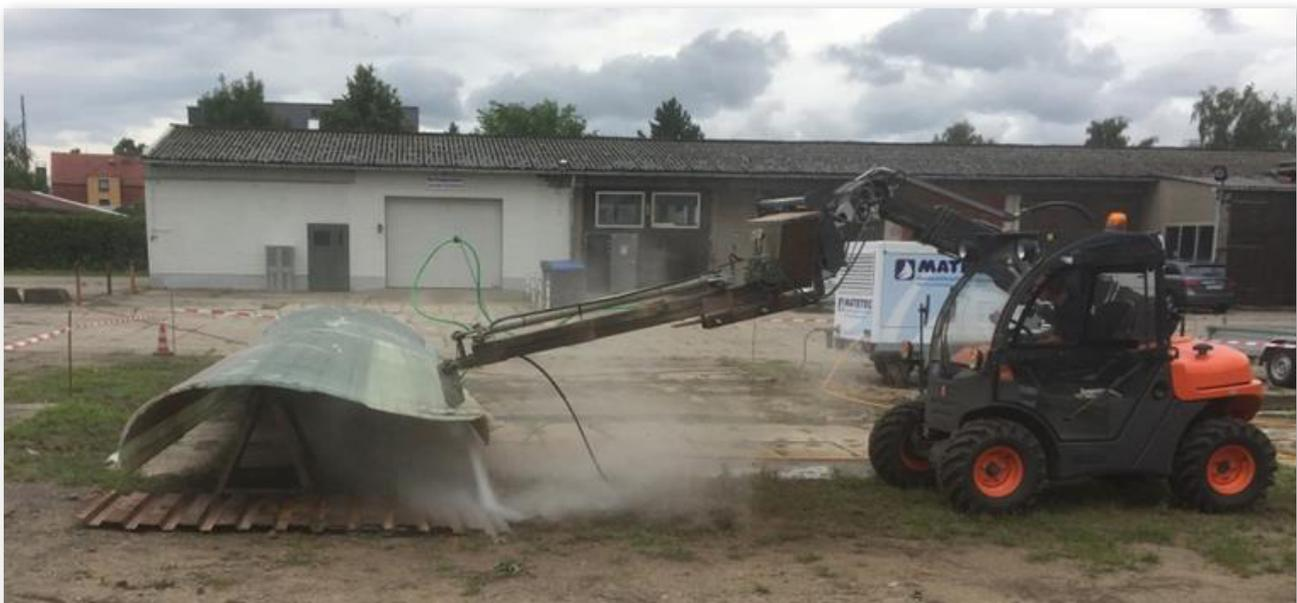
▲ **Abb. 1:** Hochdruck-Wasserstrahlschneider
