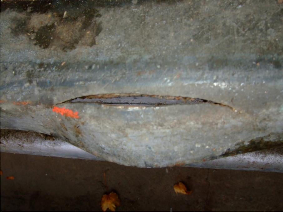
▲ **Abb. 6:** Verformung und Rissbildung an der Führungsschiene
