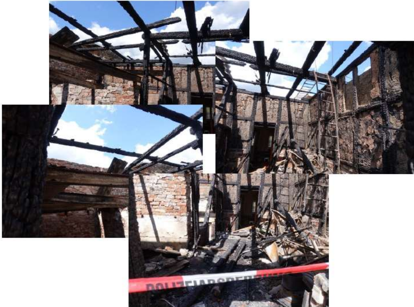
Abbildung 3: Aufnahmen vom hinteren Gebäudekomplex
